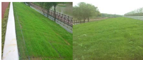
施工完成效果
