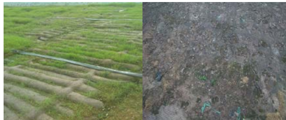
原浆砌石面卷材施工中
