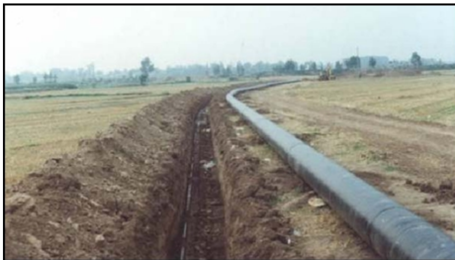
图 2.4-1 国内同类工程管线开挖实景图片
